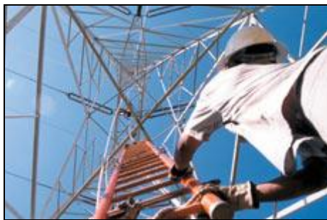
Figura 1 – vista inferior de uma torre de transmissão
