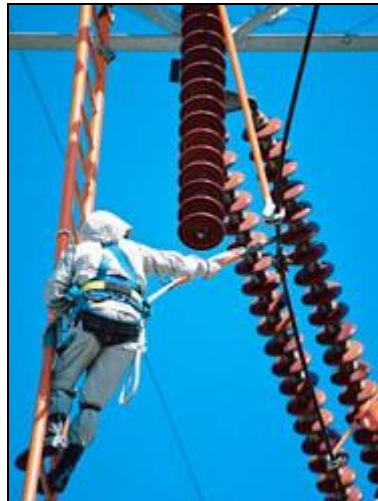
Figura 12 – manutenção de uma torre
